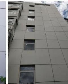
Vorhangsfassade pulverbeschichtete Stahlblechkassetten Typ 4
