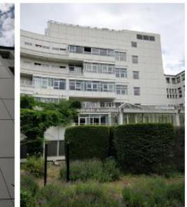
Vorhangsfassade pulverbeschichtete Stahlblechkassetten Typ 3
