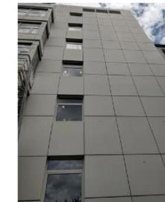
Vorhangsfassade pulverbeschichtete Stahlblechkassetten Typ 6
