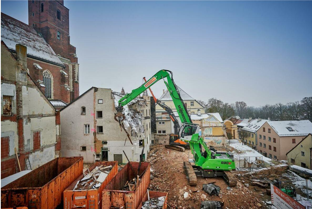
Ziel ist eine sortenreine Erfassung und größtmögliche Wiederverwertung durch, getrennten Rückbau der Gebäudebestandteile (z. B. nicht-mineralischen und mineralischen Baustoffen).
