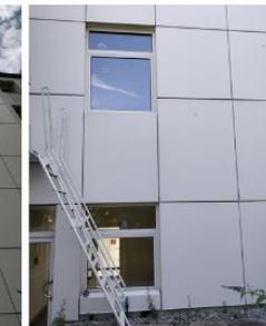
Vorhangsfassade pulverbeschichtete Stahlblechkassetten Typ 5
