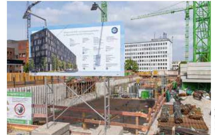
Die Baustelle des Neubaus „Algorithmus“ an der Westendstraße
